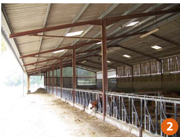
Vue intérieure stabilation
